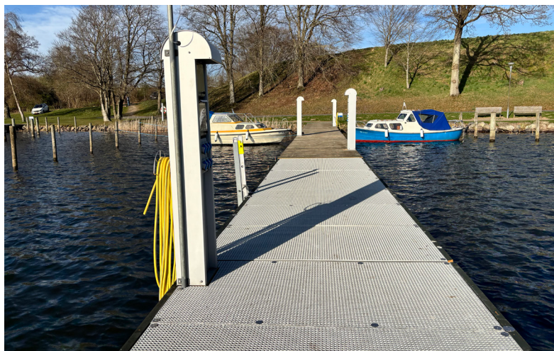
De nye glasfiberriste som den gamle træbeklædning bliver udskiftet med.
