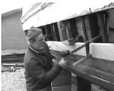
Nye planker sættes op
